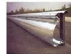
Successivamente si provvede a movimentare e posizionare le barriere dei guardrail (a doppia o tripla onda).
